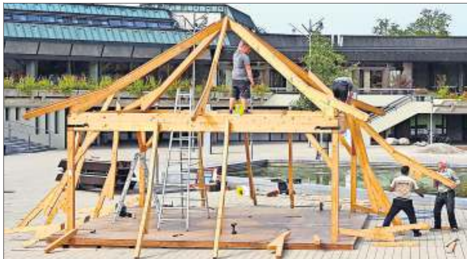
Vor der Schwabenslandhalle laufen schon die Herbst-Aufbauarbeiten. Foto: Dirk Herrmann
